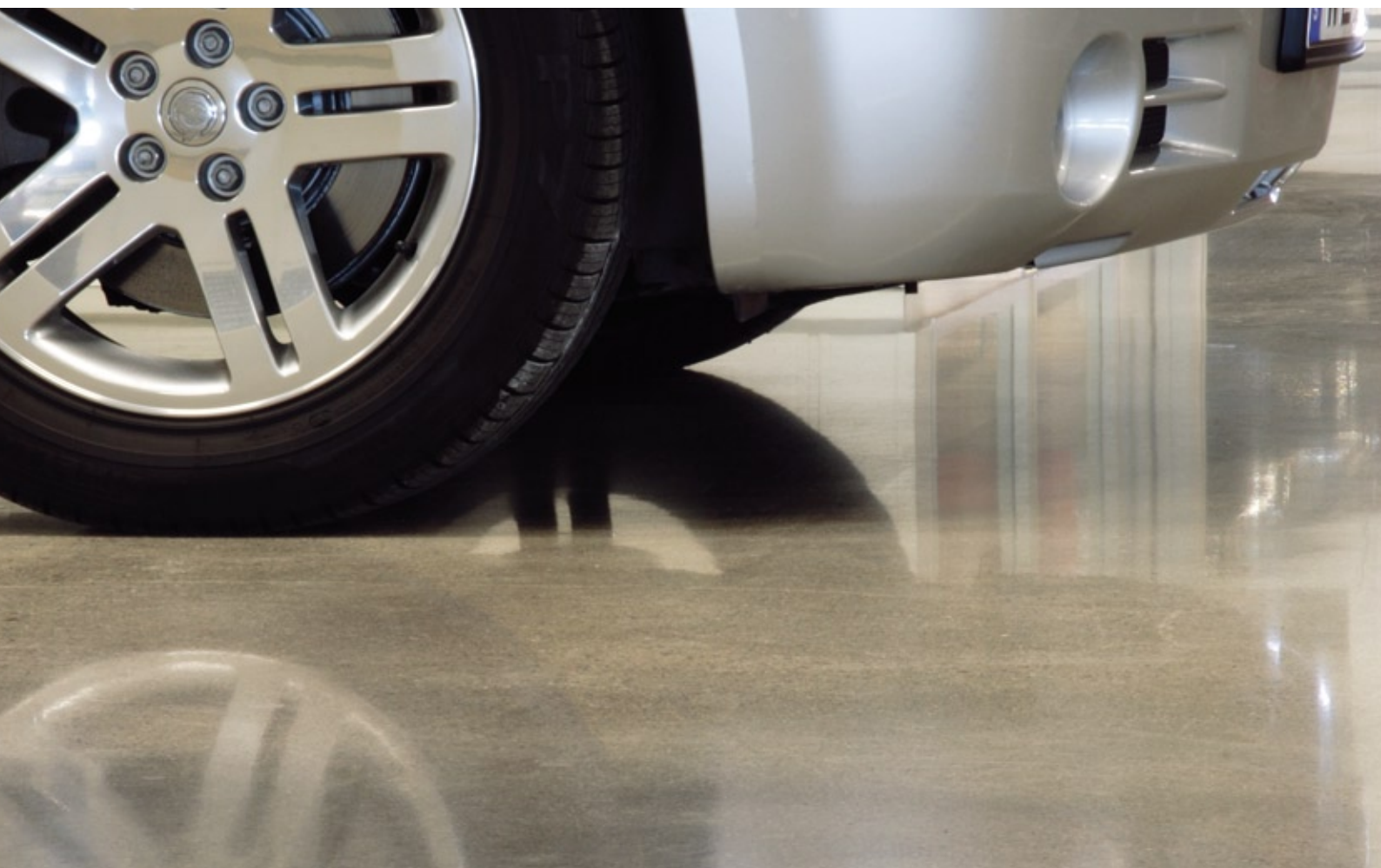
▼ Type af gulv: Beton Plads: Biludstilling
