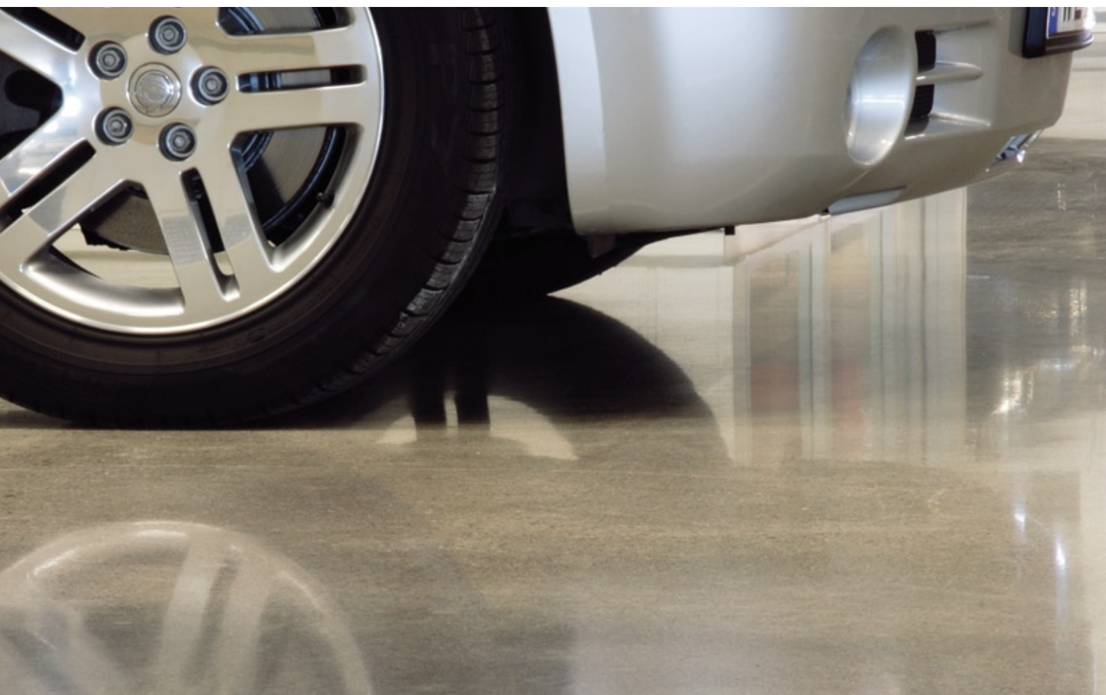
▼ Type af gulv: Beton Plads: Biludstilling
